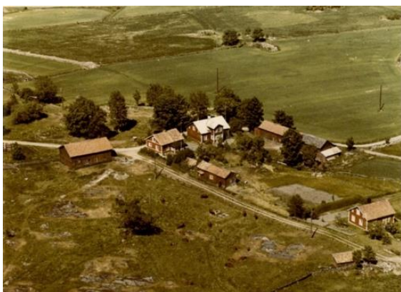
Flygfoto över Södergårdarna 1959
